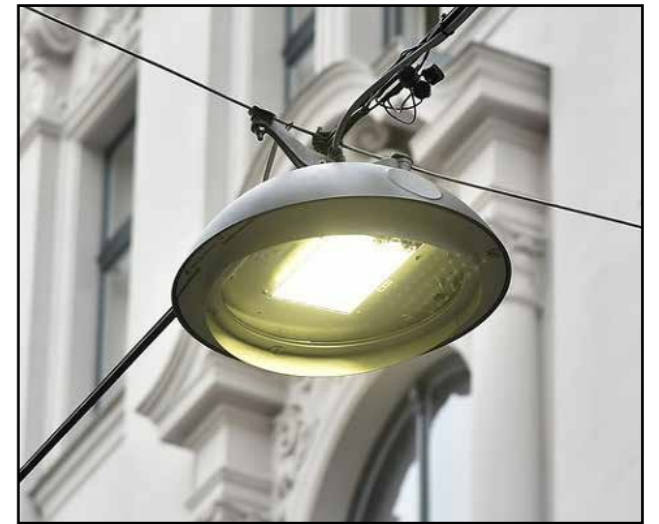
Abb. 8: Die neue Standardleuchte der Wiener MA 33. Gut erkennbar ist die am Rand montierte Blendschute.
