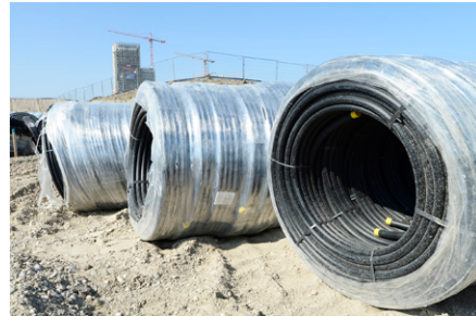
Schritt 2: Aus der Nähe betrachtet: die Erd-Sonden werden in einer Rolle als elastische Rohre angeliefert.
