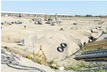
Schritt 1: Das Baugelände im Sommer 2019. Im Hintergrund ist die U-Bahn-Trasse zu sehen. Im Vordergrund liegen auf dem Erdreich zwei schwarze Rollen, das sind die Erd-Sonden.
