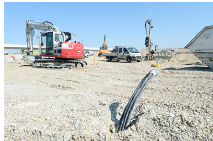
Schritt 5: Fertig: Im Bild-Vordergrund ragt eine Sonden aus dem Erdreich raus und 150 in die Tiefe.
