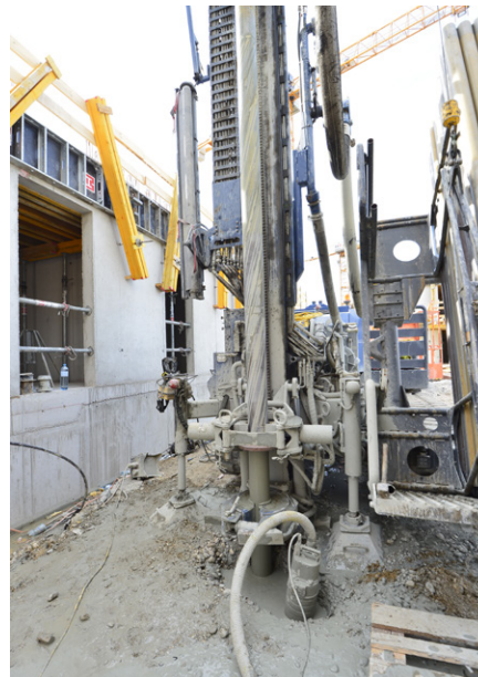
Erneuerbare Energiequellen in Kombination mit Beton: Mit insgesamt 30 Erdsonden wird Geothermie über Niedertemperatursysteme effizient genutzt. © MA 20/A. Kromus
