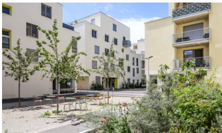
In der Mühlgrundgasse steht das erste soziale Wohnbauprojekt mit Thermischer Bauteilaktivierung zum Heizen und Kühlen. © MA20/C.Fürthner
