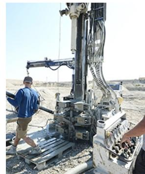
Schritt 4: Rechts im Bild ist die Steuerkonsole, mit der das Bohrggerät händisch bedient wird. An einem Tag können pro Bohrggerät bis zu zwei Sonden ins Erdreich eingebracht werden.
