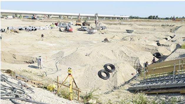
Schritt 1: Das Baugelände im Sommer 2019. Im Hintergrund ist die U-Bahn-Trasse zu sehen. Im Vordergrund liegen auf dem Erdreich zwei schwarze Rollen, das sind die Erd-Sonden.
