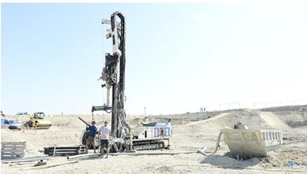
Schritt 3: Das Bohrggerät befördert die Sonden stückweise ins Erdreich. Insgesamt sind über 9.000 Hebelbewegungen notwendig, um eine Sonde 150 m in den Boden zu bringen.
