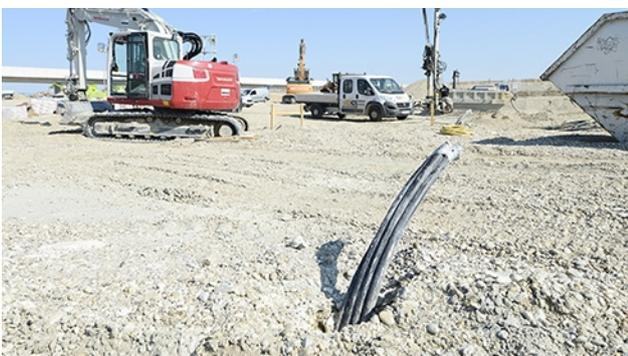
Schritt 5: Fertig: Im Bild-Vordergrund ragt eine Sonde aus dem Erdreich raus und 150 in die Tiefe.
