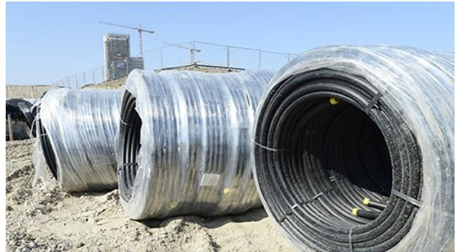
Schritt 2: Aus der Nähe betrachtet: die Erd-Sonden werden in einer Rolle als elastische Rohre angeliefert.
