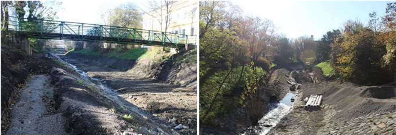
Beginn der Bauarbeiten im Abschnitt 4 © Stadt Wien – Wiener Gewässer
