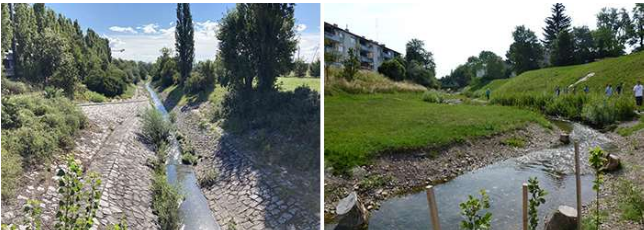
Verbaute Strecke und renaturierte Strecke an der Liesing © Stadt Wien – Wiener Gewässer
