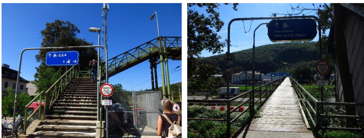
Abbildung 36: Steg über den Bahnhof Unterpurkersdorf.
