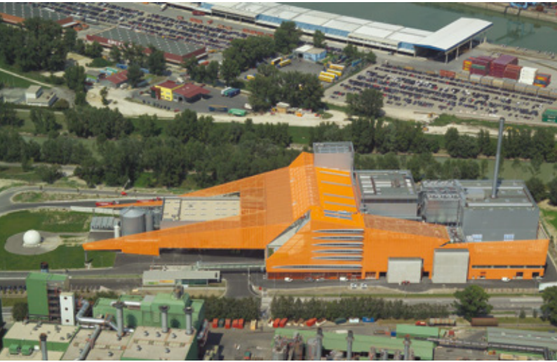
Biogas Wien, Müllverbrennungsanlage Pfaffenau
