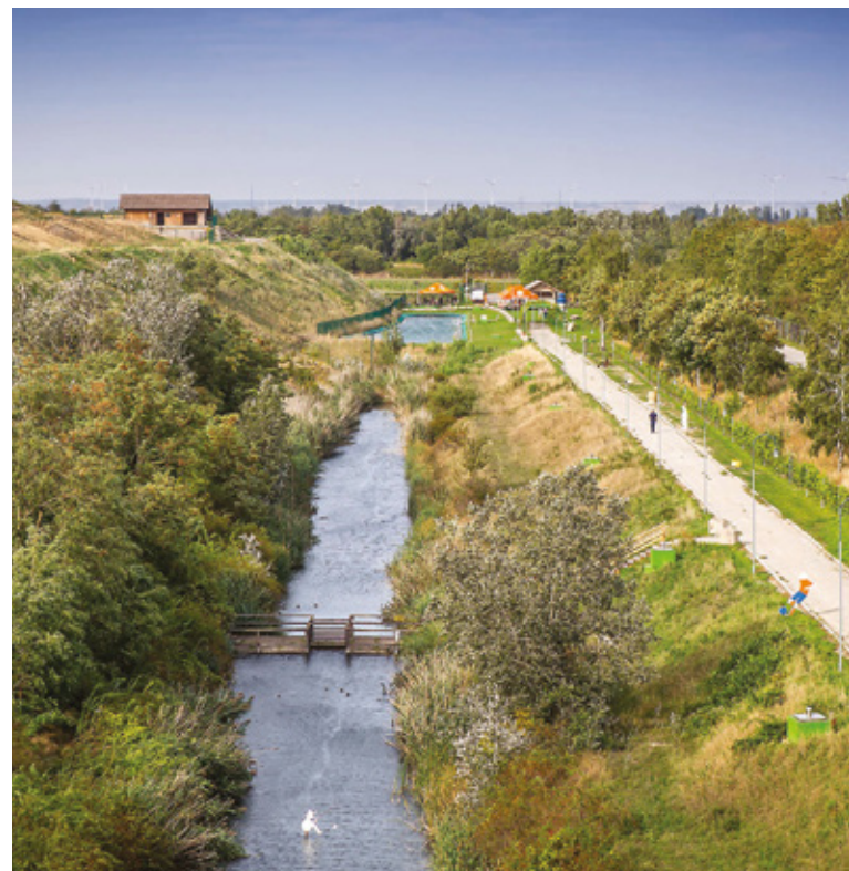
Lösch- und Beregnungsteiche der Deponie Rautenweg
