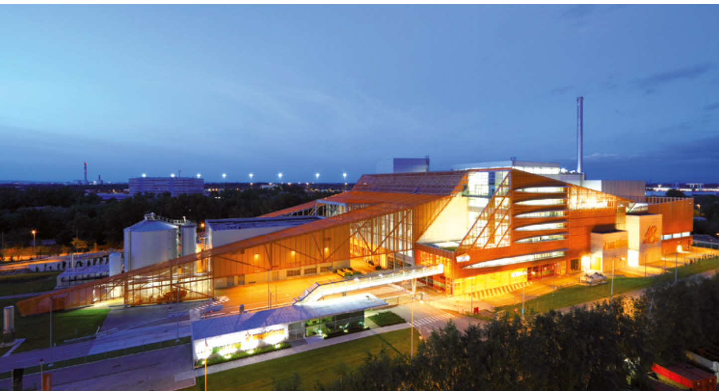
Biogas Wien und Müllverbrennungsanlage Pfaffenau
