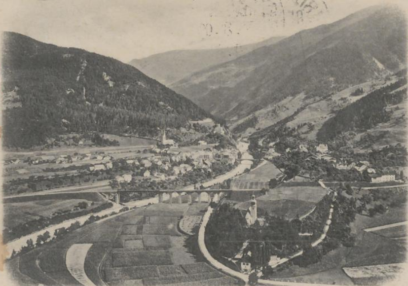
von Herrn J. Gusch. Sandeck von Norden (Arlbergbahn)
