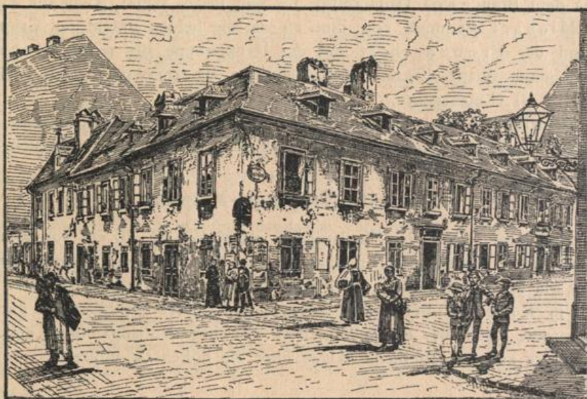
Fig. 184. Ansicht des Hauses „zum scharfen Eck“ Nr. 119 (neu 35).
