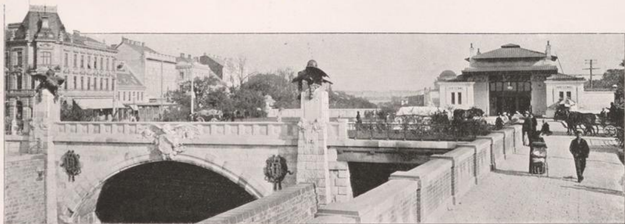
HIEZINGER BRÜCKE. (Architekten: R. KRIEGHAMMER und F. OHMANN.)
