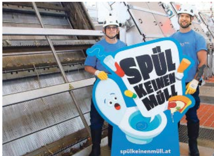
Zwei Mitarbeiter der ebswien kontrollieren den offenen Grobrechen.
