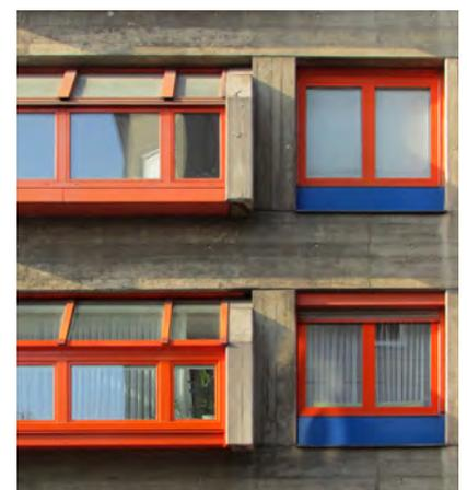
1160, Kirchstetterngasse 19. Um 1980. Kunststofffenster mit breiten Profilen, hier als Farbkontrast in einer Sichtbetonfassade eingesetzt.
