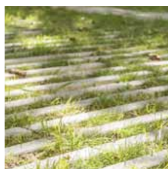
Pflaster mit Rasenfuge
