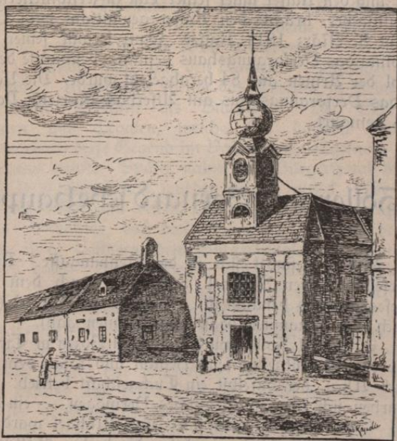
Das Versorgungshaus „Langenkeller“.
