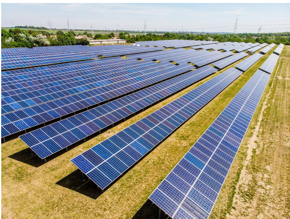
Photovoltaik-Wasserbehälter Unterlaa, Copyright: MA 20-Christian Fürthner
