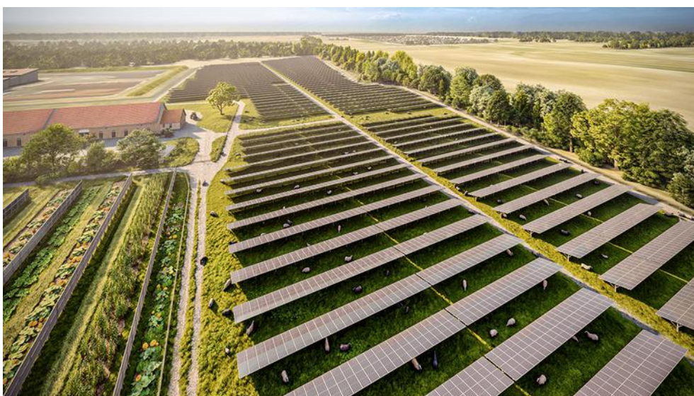
Photovoltaikkraftwerk Schafflerhof, Copyright: Wien Energie
