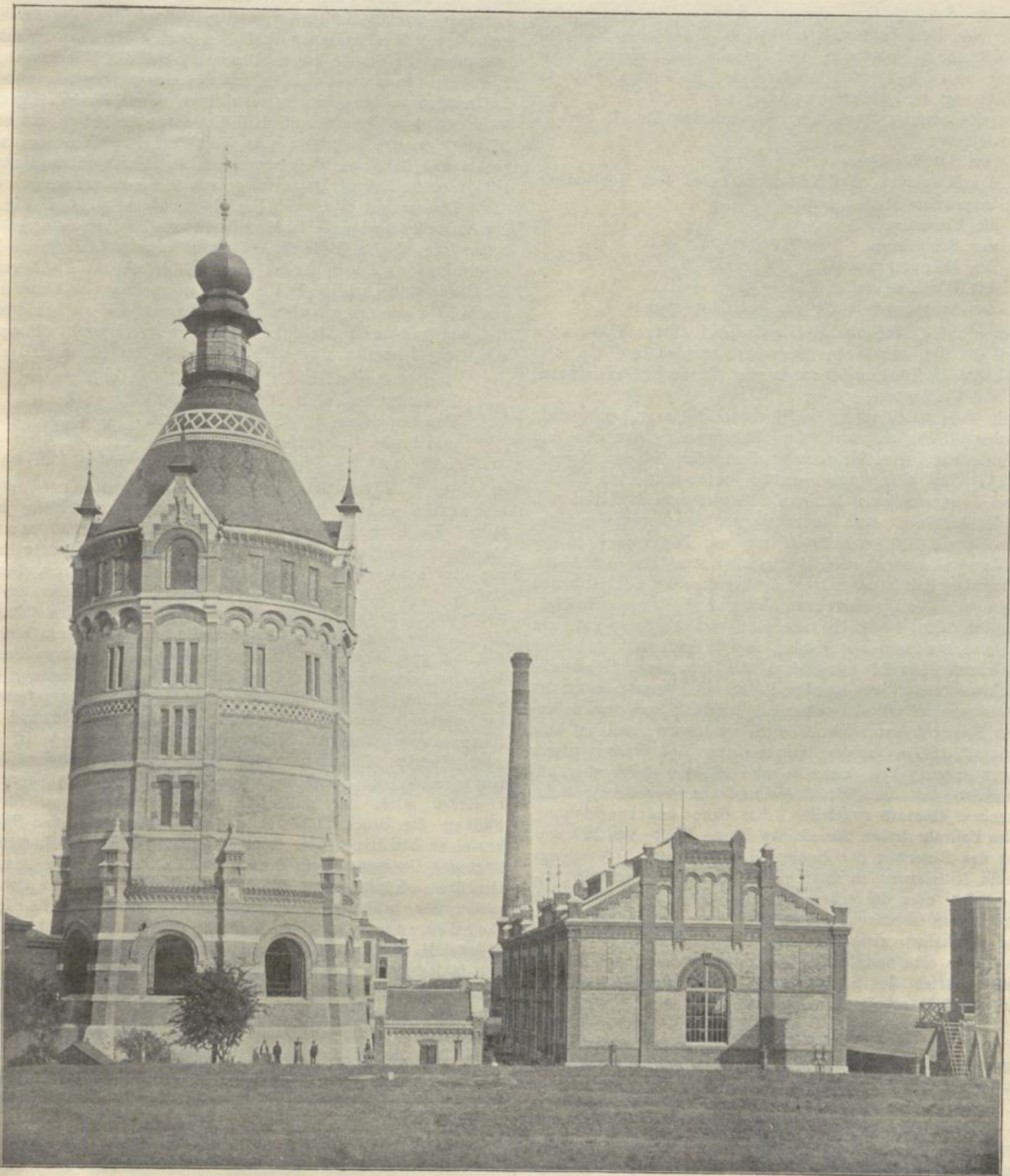
Fig. 1. Ansicht des Wasserthurmes und Maschinenhauses.
