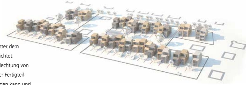
Angrenzend an die weitläufigen Grünflächen hinter dem Wiener Prater wurde diese Reihenhausanlage errichtet. Das Konzept besteht durch eine geschickte Verflechtung von modularer, günstiger und ökologisch nachhaltiger Fertigteil-Bauweise, die auch später leicht demontiert werden kann und vollständig recycelbar ist.
