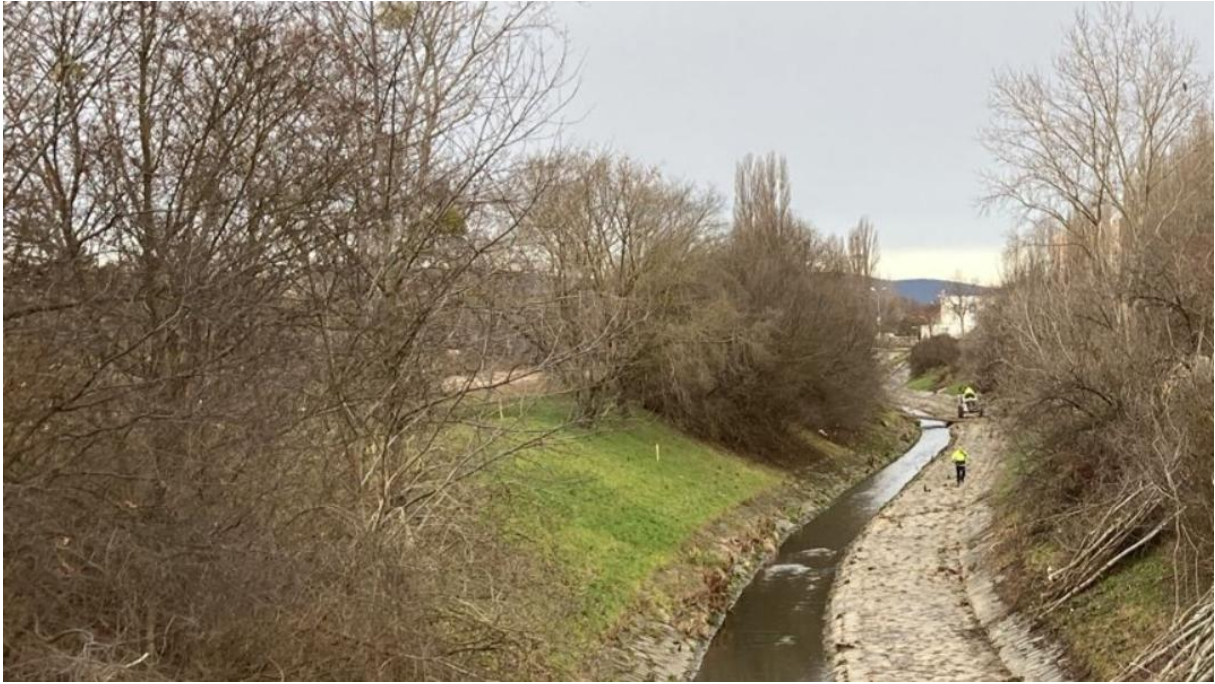
Hart verbauter Abschnitt an der Liesing © Stadt Wien – Wiener Gewässer
