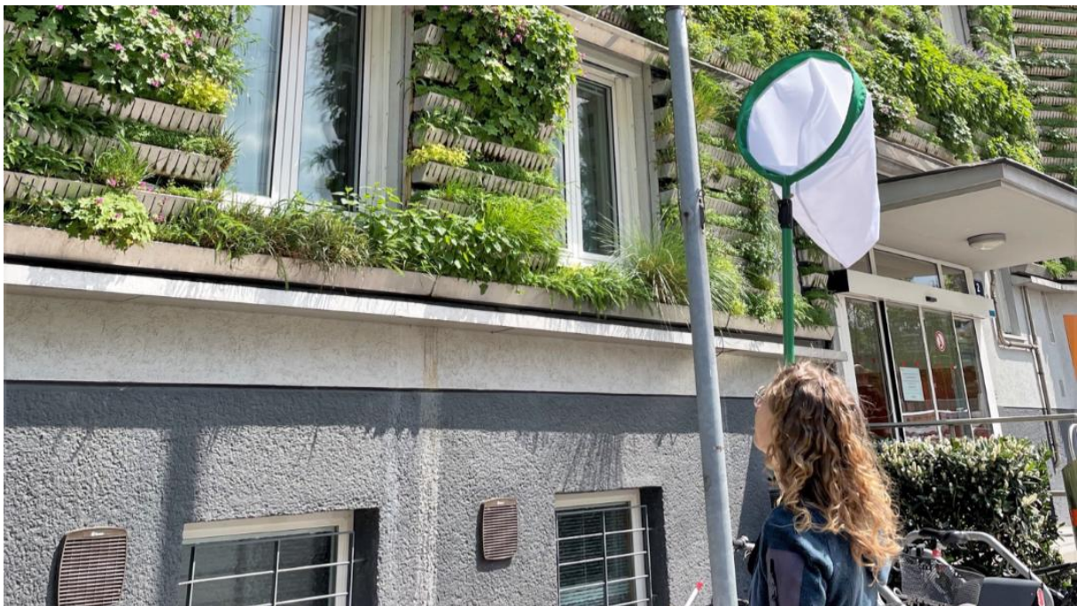
Grünfassade der Stadt Wien – Abfallwirtschaft, Straßenreinigung und Fuhrpark (MA 48), Einsiedlergasse © Stadt Wien – Umweltschutz
