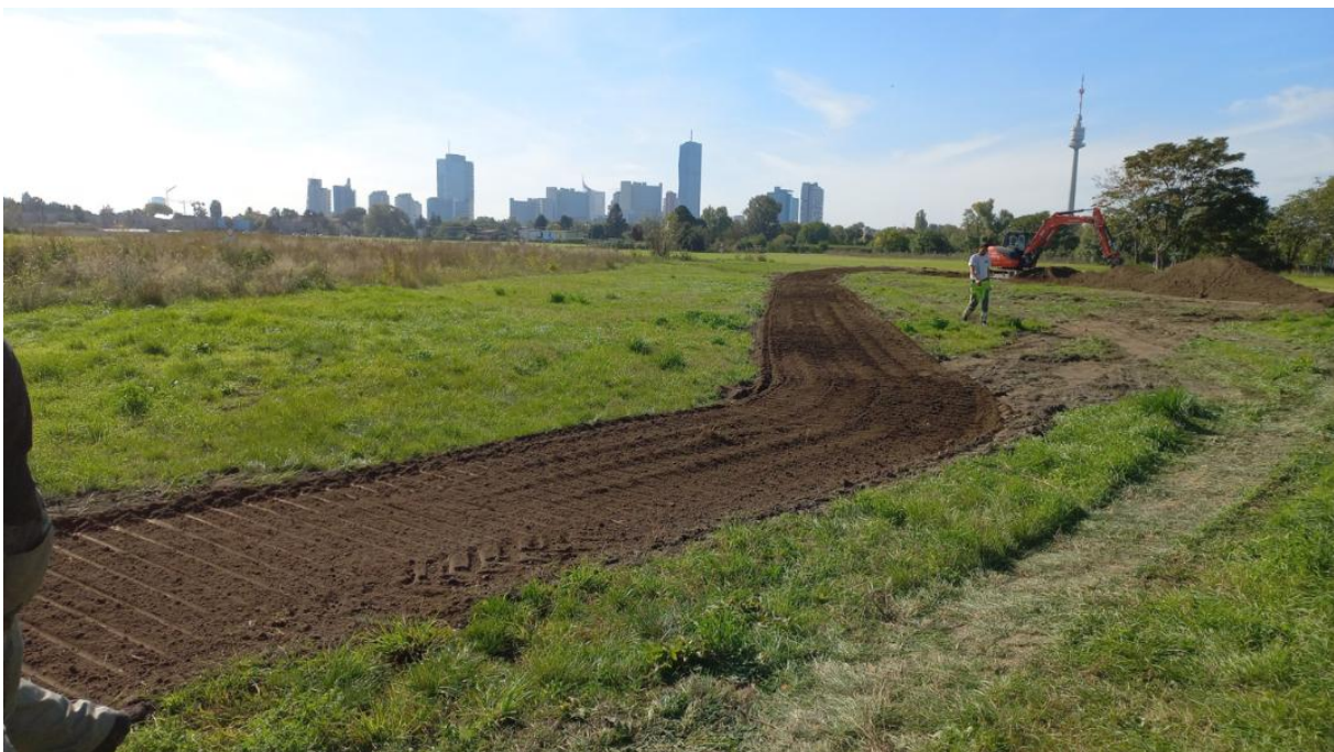
Der Grüne Weg wird gebaut © Stadt Wien – Klima, Forst- und Landwirtschaftsbetrieb
