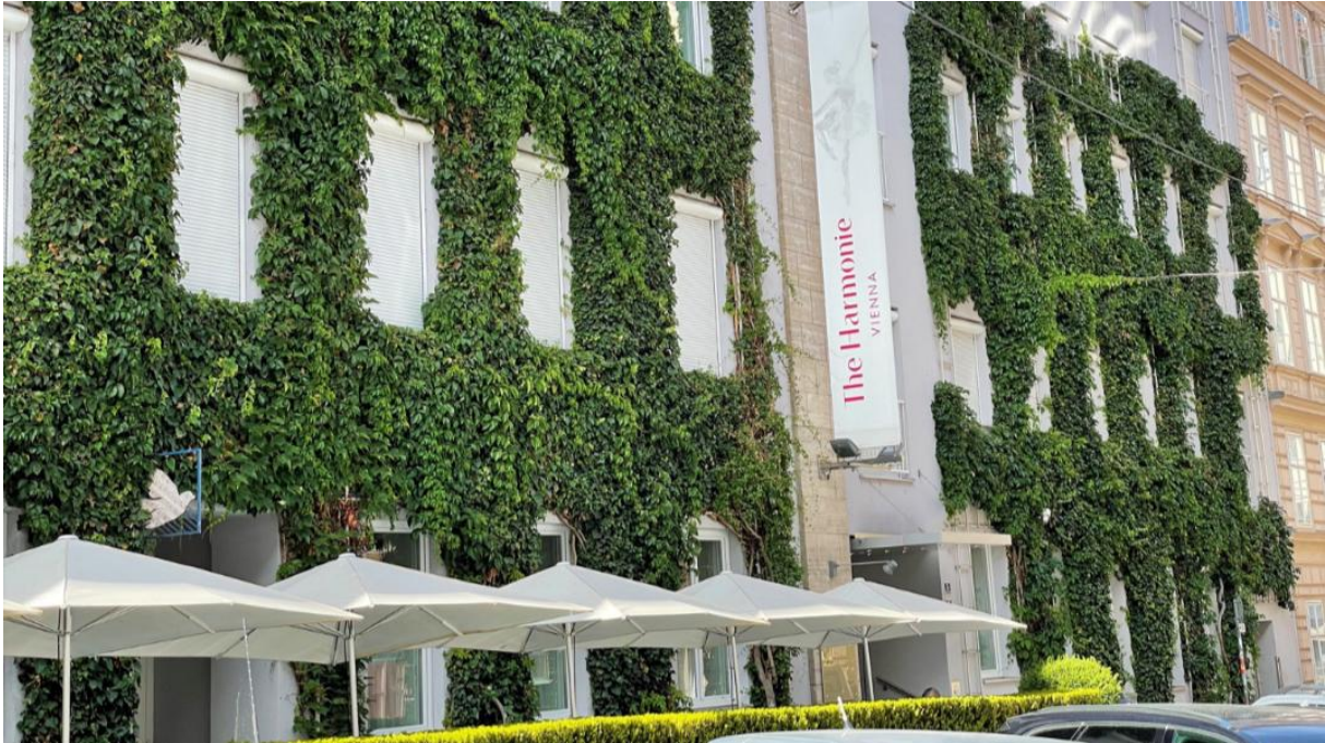
Versuchsfläche 9, Hotel Harmoniegasse 5-7, 1090 Wien © Stadt Wien - Umweltschutz
