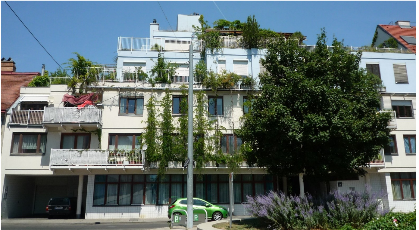
Fassadenansicht © B.R.O.T. Haus Hernals
