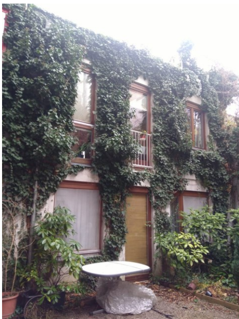
Detail Innenhof © B.R.O.T. Haus Hernals
