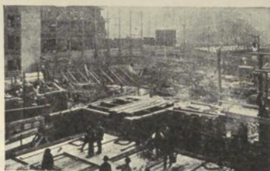
Blick vom Baugerüst.
