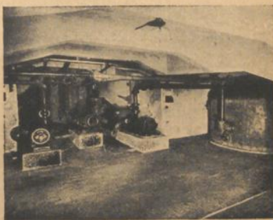
Wasserreinigungsanlage. (Unter der großen Schwimmhalle.)
