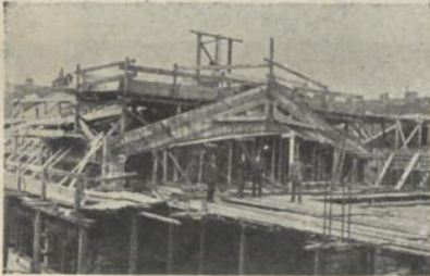
Hallen im Bau.
