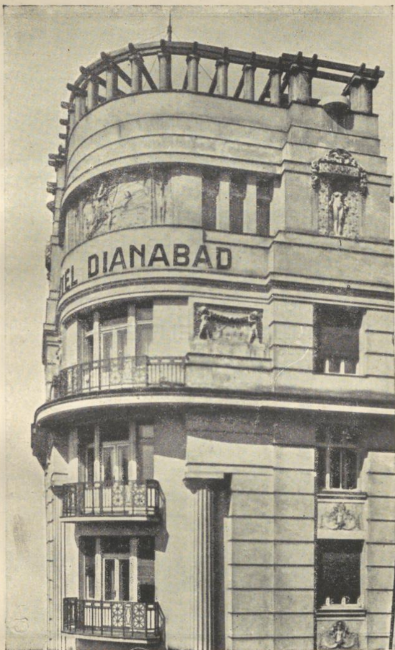
Fassade, Eckausbildung. (Architekt P. P. Brang.)
