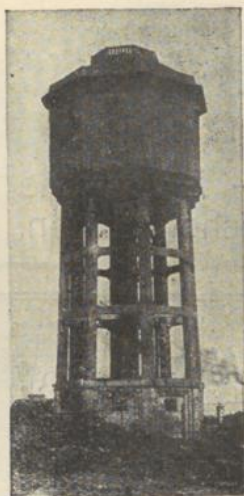
Wasserturm in Blumau für 1000 m 3 Inhalt.
