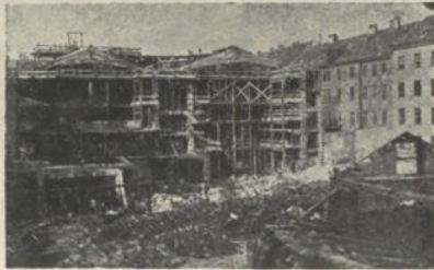
Hallen im Bau.
