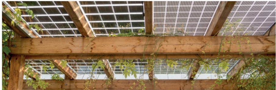
Abb. 15: PV-Pergola BOKU, IBLB: Zwei Modultypen mit unterschiedlichen Lichtdurchlässigkeiten kommen hier zum Einsatz (Weidmann-Krieger, 2022)
