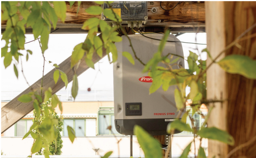
Abb. 21: Wechselrichter im PV-Dachgarten BOKU-IBLB (Markus Weidmann-Krieger, 2022)
