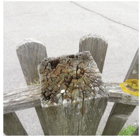
Eine weitere Möglichkeit, Holz vor eindringendem Niederschlagswasser zu schützen stellt das Abdecken bzw. Verblenden des Holzteils dar. Hierbei sollte darauf geachtet werden, dass ein Austrocknen des Holzes durch die Abdeckung nicht verhindert wird. Dies kann durch Hinterlüftung sichergestellt werden.
