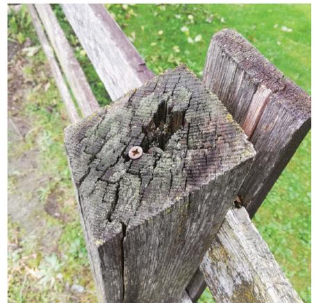
Neben Niederschlagswasser kann auch aufsteigendes Wasser bzw. Spritzwasser zu Holzschäden führen. Holzkonstruktionen sind so auszuführen, dass Wasser nicht vom Boden in das Bauteil aufsteigen kann. Die Spritzwasserzone ist nach Möglichkeit konstruktiv zu schützen.
