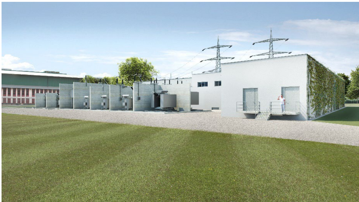
Abbildung: Das Umspannwerk Simmering wurde modernisiert. © Wiener Netze
