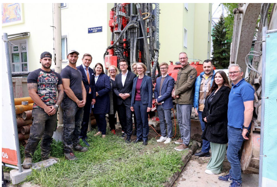
Abbildung: Start der Tiefenbohrungen für den Gemeindebau Deutschordenstraße. © PID, Votava
