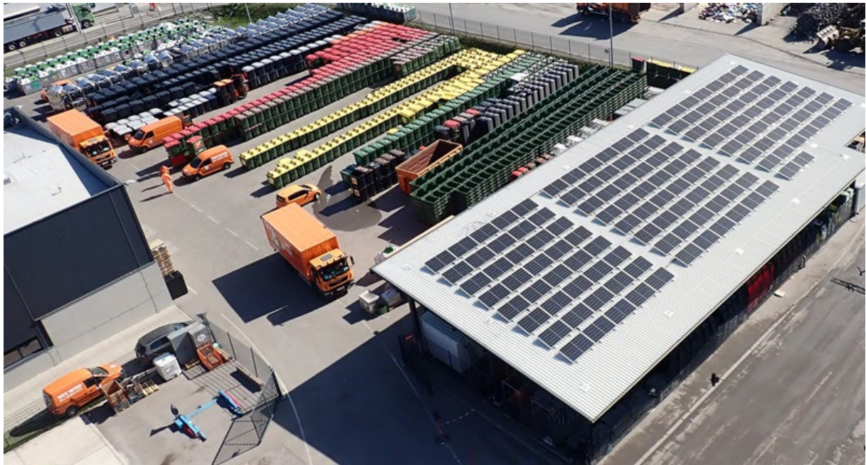
Abbildung: Die neue PV-Anlage auf dem Behälterlogistikzentrum Nord (BLZ). © Stadt Wien – Abfallwirtschaft, Straßenreinigung, Fuhrpark (MA 48)
