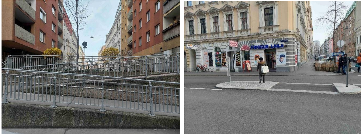
Abbildung 14 Barrierefreie Stufenanlage Gießaufgasse und Querungshilfe über die Arbeitergasse
